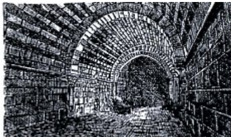
231. Intérieure de l'église de Montredon.
